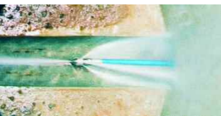
Rohrreinigungsschlauch mit 3/8" Düse - Reinigung der Abwasserrohre (150 - 200 mm Durchmesser) einer Steinzeug-Fabrik
