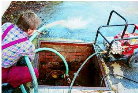
Trockenlegung eines Domschachtes mit dem Schlamm-sauger - das Hochdruckwasser reißt das Schmutzwasser mit sich
