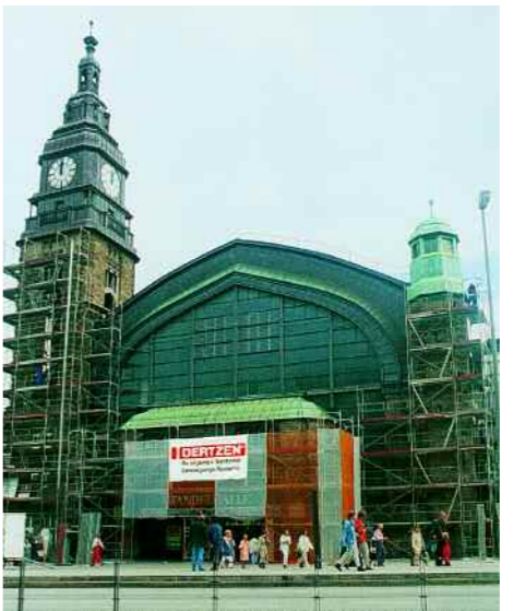
OERTZEN-Geräte reinigen die Sandsteinfassade des Hamburger Hauptbahnhofes
